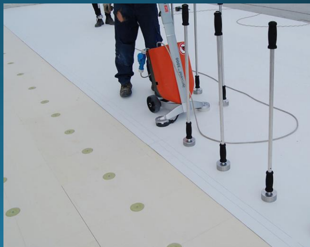
Fase di saldatura
