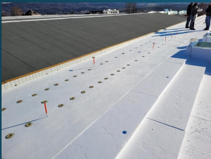
Posa fissaggi ad induzione
